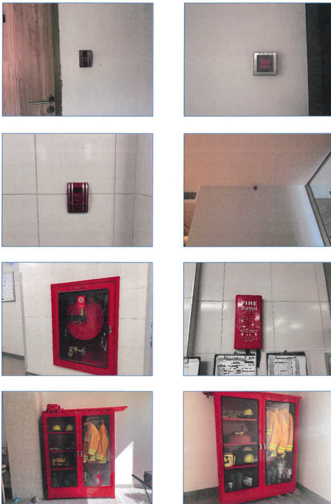
ภาพถ่ายที่ 2.2-17 ระบบแจ้งเตือนอัคคีภัยและป้องกันอัคคีภัยภายในโรงแรม
