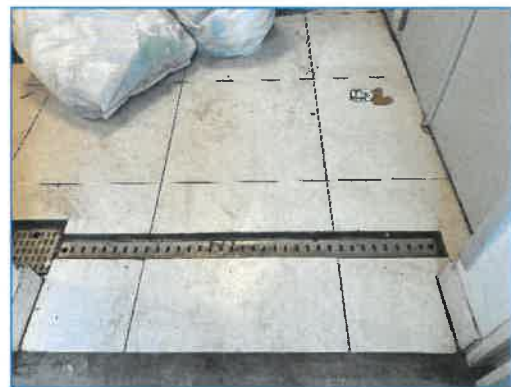
ระบบรวมน้ำเสียหลังล้างห้องพักรวม
